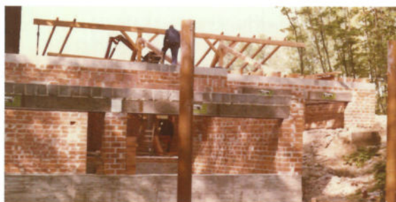
Dachstuhl Errichtung
