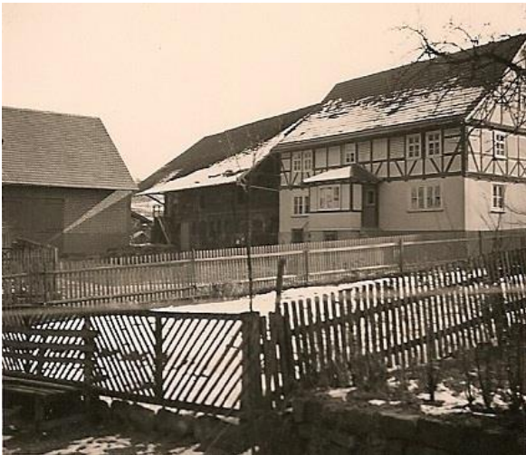
Nr. 7 Scheune Fridrich Lange gebaut 1958
