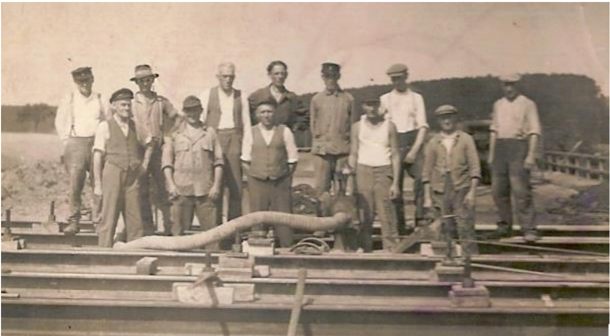
Bauarbeiten an der Autobahnbrücke
