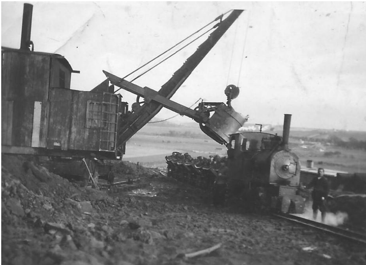
Bau der Autobahn
